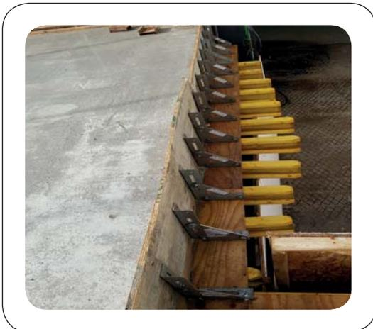
600 mm Platte abgewinkelt / abgeschrägt, beweist Flexibilität
